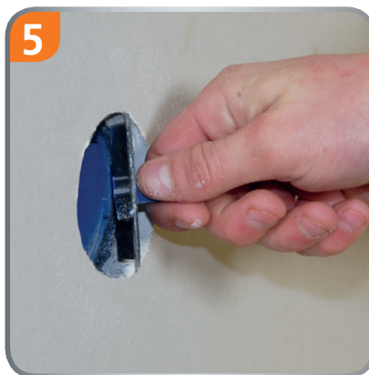
5 Bohrdeckel entfernen.
