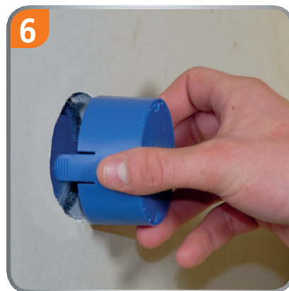
6 Aufstecken des Dosenoberteils.
